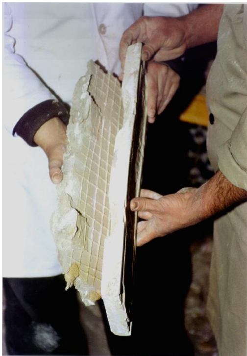
Figura 5. Placa desmontada en Sala de Abencerrajes
